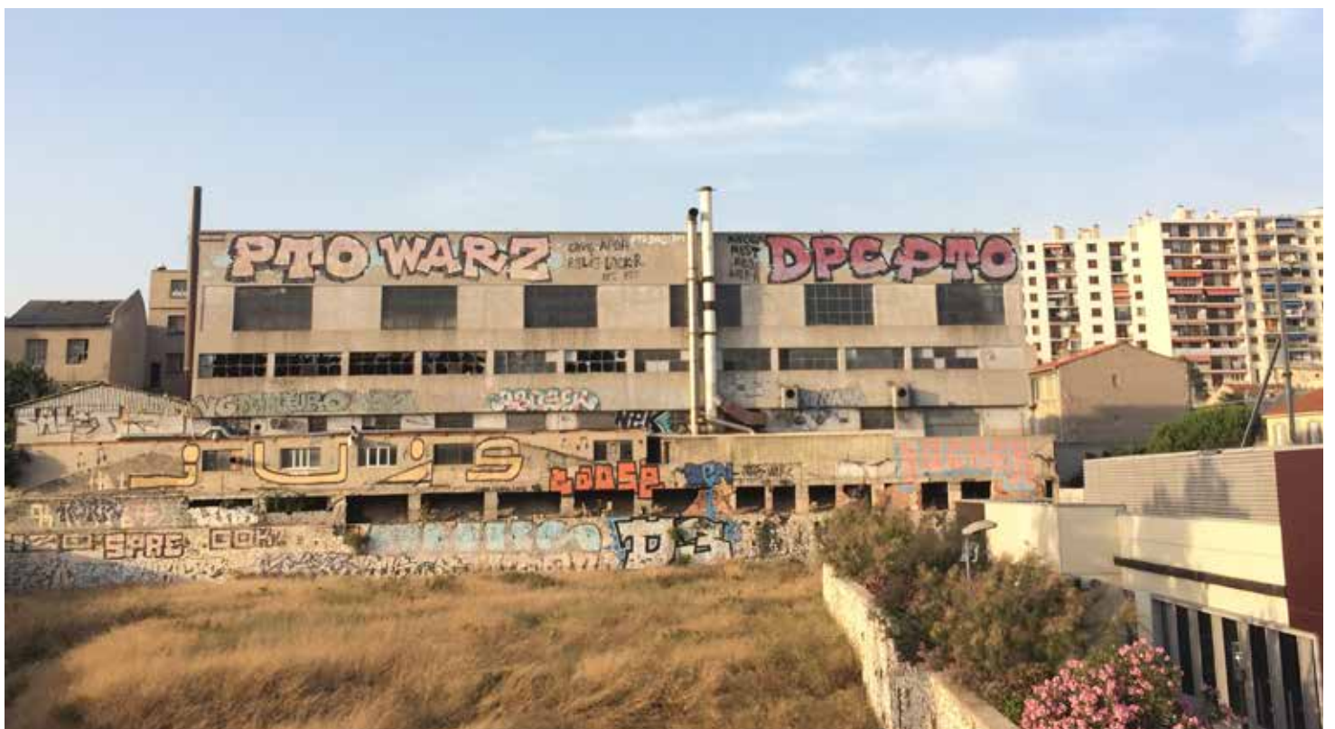
Façade de l'usine Pillard vue de l'auto-pont
