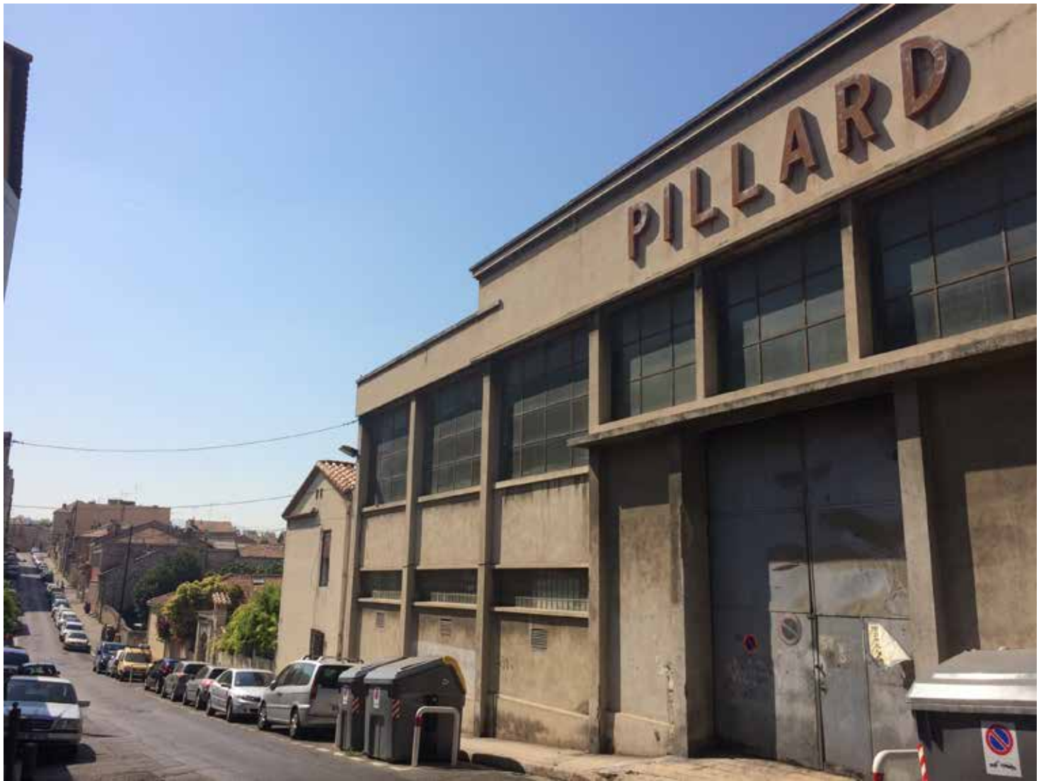
Façade de l'usine Pillard côté boulevard Paul Arène
